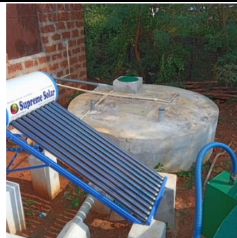
Pre-Digester Tank (10 Cu M)
